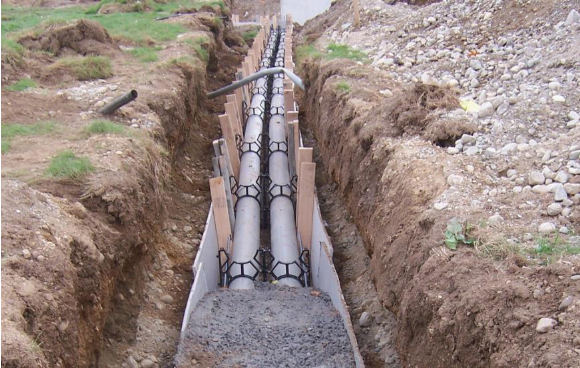
Picture of Conduit Installation Before Concrete Pour
